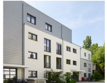
Wohnanlage, Köln, Deutschland
