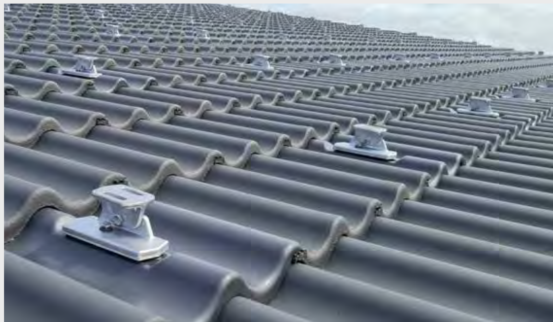
Abb. zeigt Grundpfannen mit Trägerelement im eingebauten Zustand
