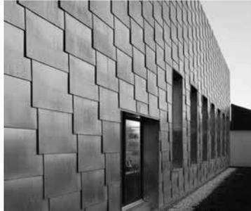
**BLANK-ZINC:** Der Klassiker bei Fassaden- oder Bedachungssystemen. Das Material wird von unseren Werken walzblank geliefert und bildet dann am Objekt im Laufe der Zeit durch die Bewitterung eine mattgraue Schutzschicht, die Patina. Nicht zuletzt deshalb wird Titanzink auch als lebender Baustoff bezeichnet.
