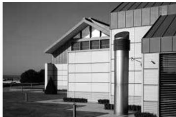
**QUARTZ-ZINC:** Nach dem Walzen durchläuft das (walzblanke) Titanzink einen Vorbewitterungsprozess. Dadurch entsteht eine homogene hellgraue Oberflächenoptik mit einem ganz eigenen, satinierten Glanz. Und, – was für Planer nicht unwichtig ist, auch die gewünschte gleichmäßige Charakteristik der Oberfläche über viele Jahre.
