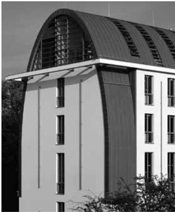
**VMZ SYSTEM:** Die Idee, die hinter dem VMZ SYSTEM steht, war eine wirkungsvolle Drainageebene zwischen Zinkeindeckung und Unterkonstruktion zu schaffen. Eine, die sich ideal für den Einsatz in kritischen Dachbereichen eignet:
