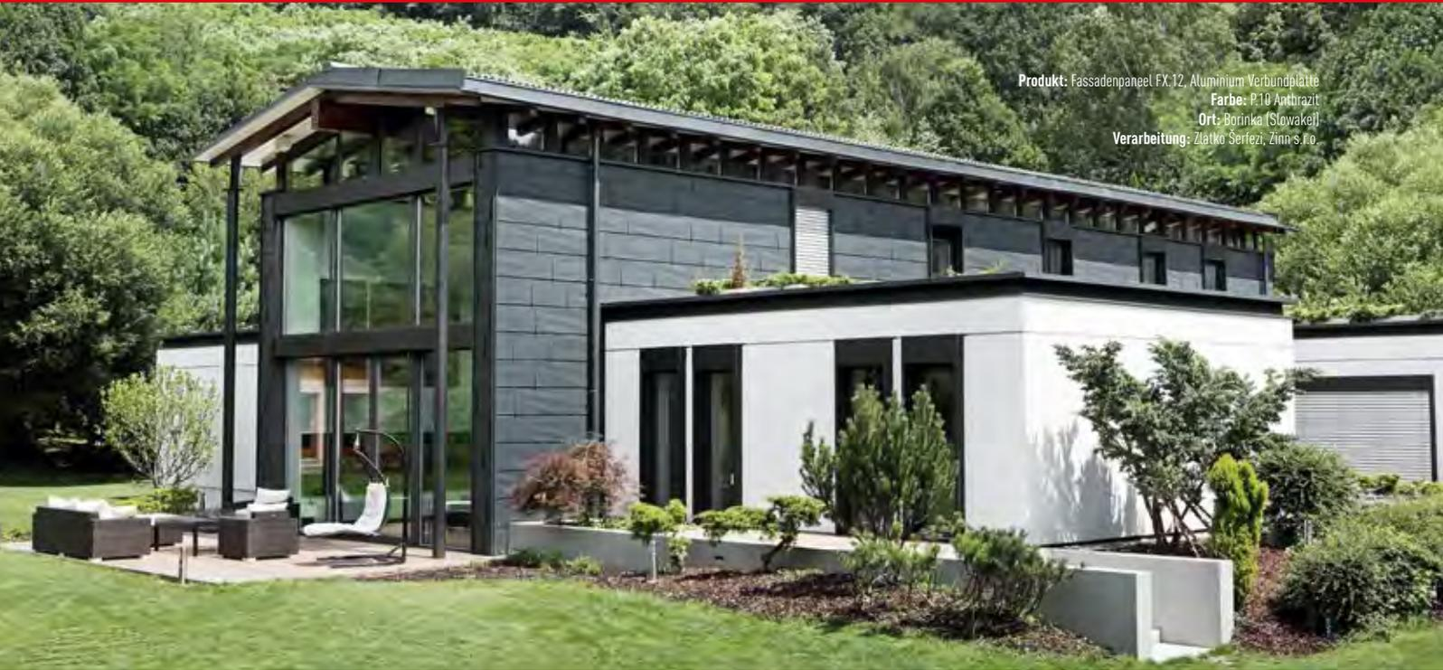
Produkt: Fassadenpaneel FX.12, Aluminium Verbundplatte
